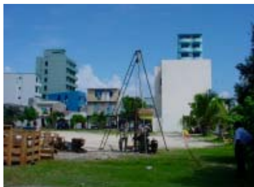
ボーリング調査実施風景
