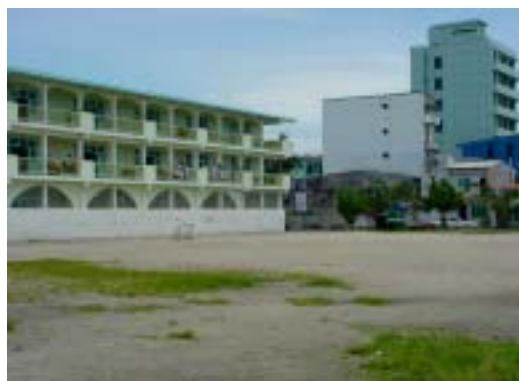
建設予定サイト（1） （北東側：左側は既存校舎）
