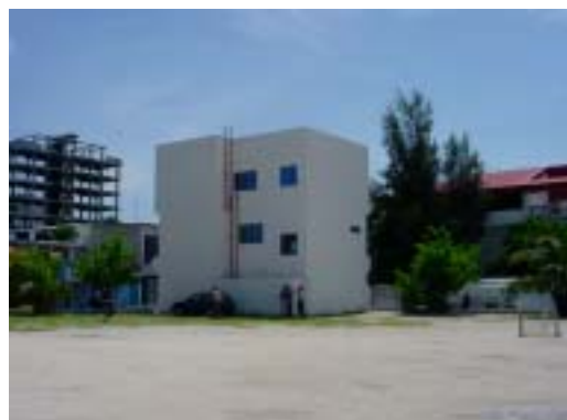
建設予定サイト（2） （南東側：中央は地域警察事務所）
