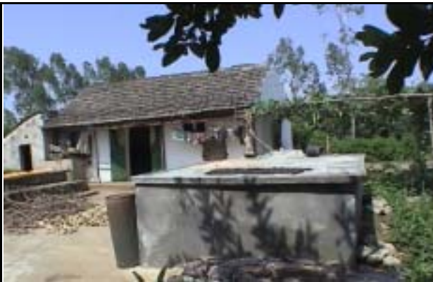
雨水貯留タンク
