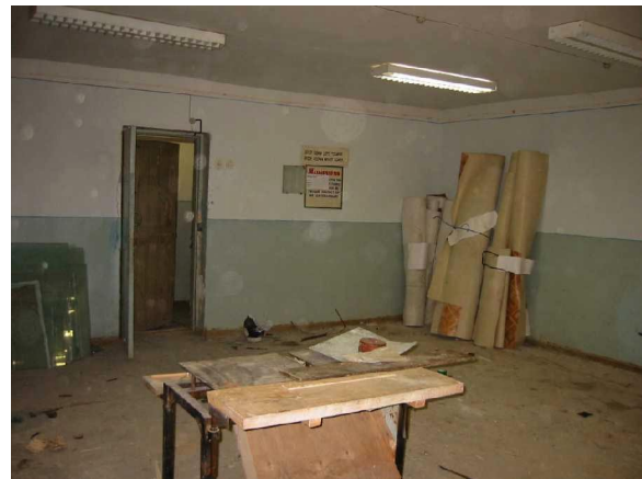
改修中の1階（実習室を予定）
