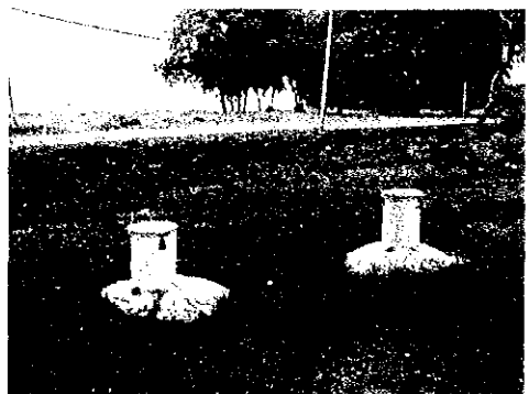
完成した新設観測井の一部 2001/9/13
