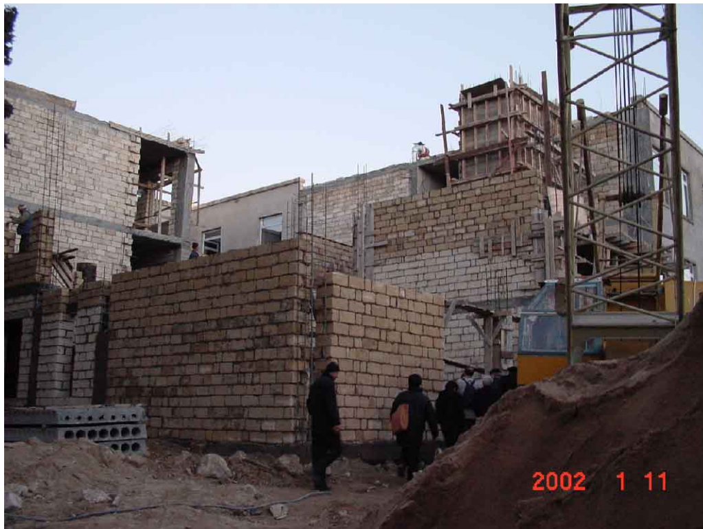
建築現場写真
