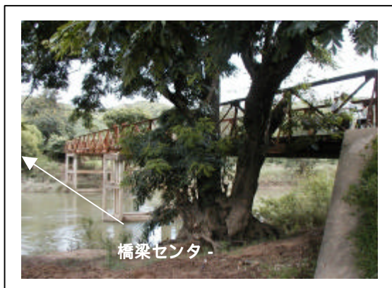
Photo-5 NO.56 Krong K'Ma Bridge (Dac Lac Prov.)
