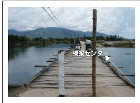
Photo-8 NO.83 Ngoi Ngan Bridge (Khan Hoa Prov.)
