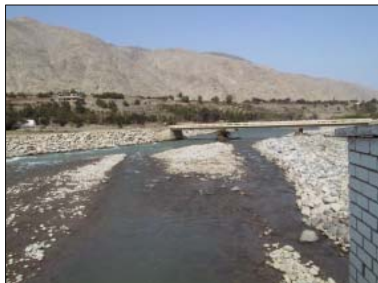
Vista hacia Aguas Arriba desba la Estación de Afores Socsi
