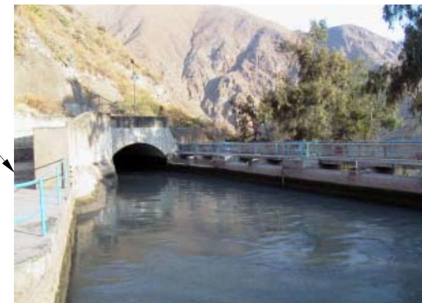
Salida del Tunnel de la Central Hidroeléctrica Matucana en el Sitio de Conexión con el Tranque de Carga de la Central Hidroeléctrica Callahuanca
