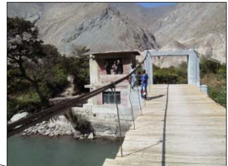
Estación de Aforos Chavin
