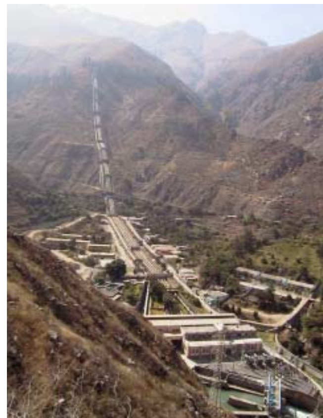
Central Hidroeléctrica Callahuanca: Los excedentes de agua son vertidos al Río Santa Eulalia
