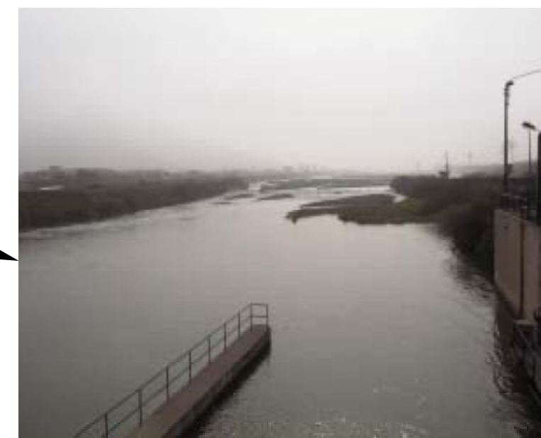
Vista hacia aguas arriba de la Bocatoma La Atarjea
