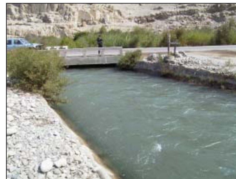
Canal de Irrigación en Nueva Imperial
