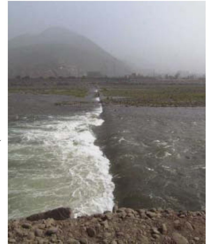
El Río Rímac Aguas Arriba de La Atarje: Obras de Concreto de Ampliación del río con fines de recarga del Acuífero
