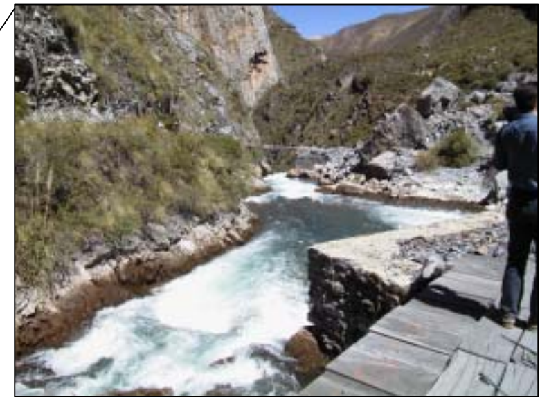
Desagüe de la Laguna Piquicocha
