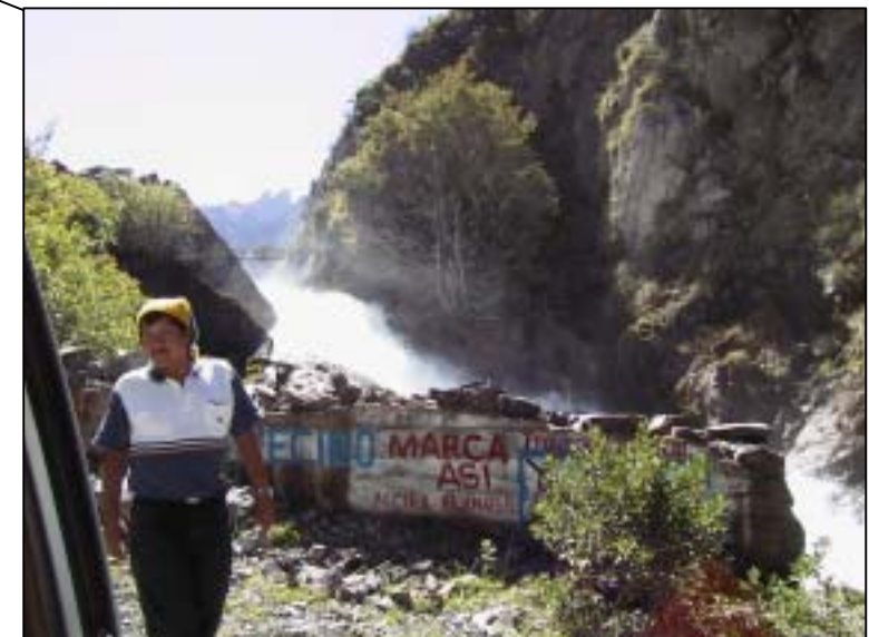
Desagüe de la Laguna Piquicocha
