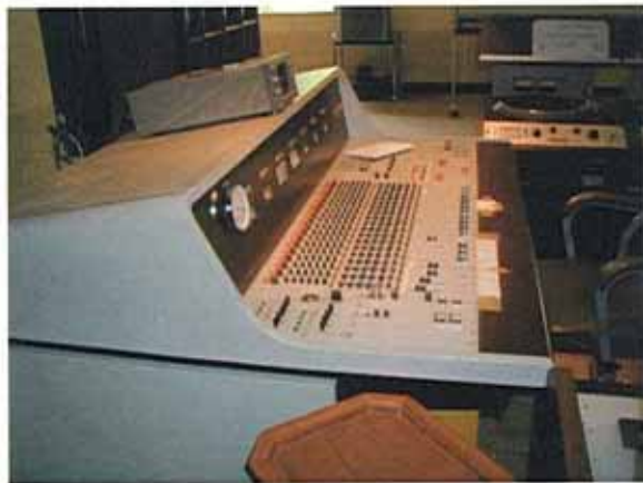
ラジオ制作スタジオ副調整室
