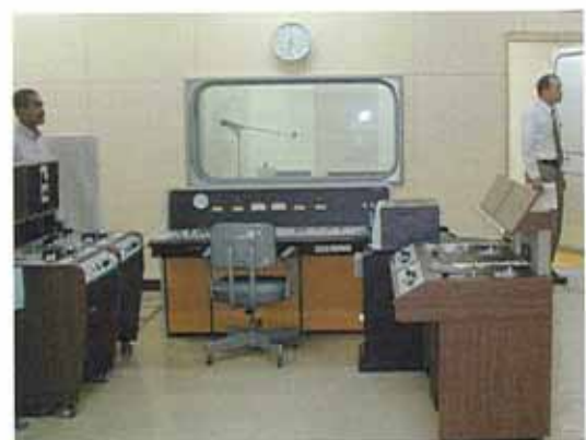
コンティニューティスタジオ副調整室
