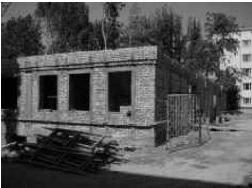
ER棟（建築中、5月）
