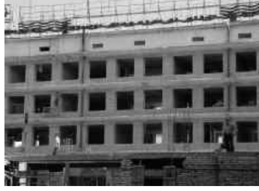
診断棟（改修中、5月）
