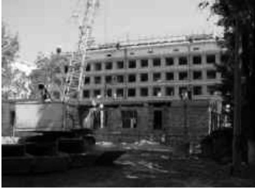
診断棟（改修中、5月）
