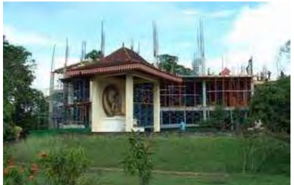
仏陀像と電子・通信工学科新校舎建設現場
