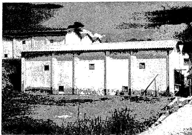
レンガ壁スレート屋根 棚5段 165m 2
