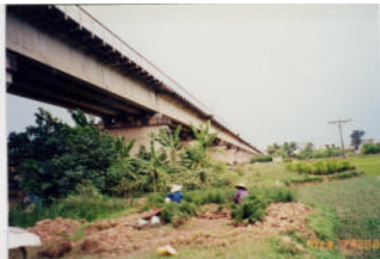
ドンガク地区の南端に見える鉄道高架橋
