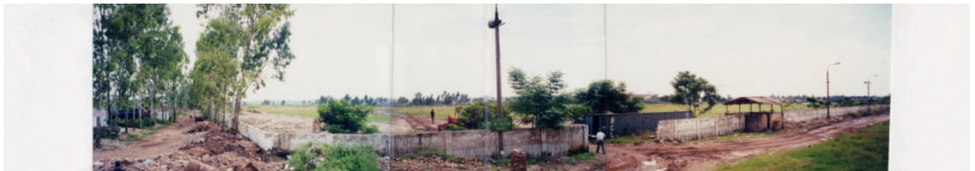
建設廃材専用埋立処分地（ラムズ地区）
