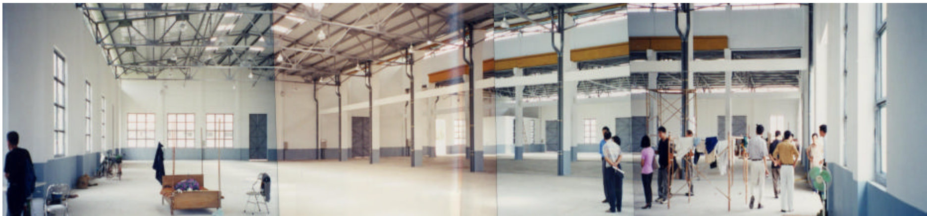
完成した新機械整備工場の建物の中。ここで、ゴミ運搬車両の定期点検や整備、故障車両の修理の他、ゴミ収集ハンドカートも製造する。
