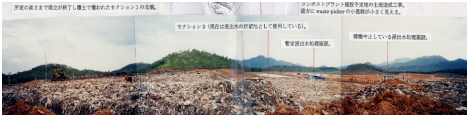
ナムソン最終処分場第1期、埋立中のセクション2から南へ眺める全景
