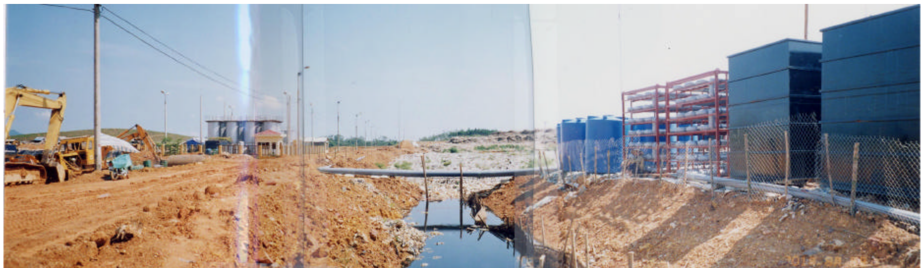
稼働中止の浸出水処理施設 (左)、及び暫定浸出水処理施設 (右)
