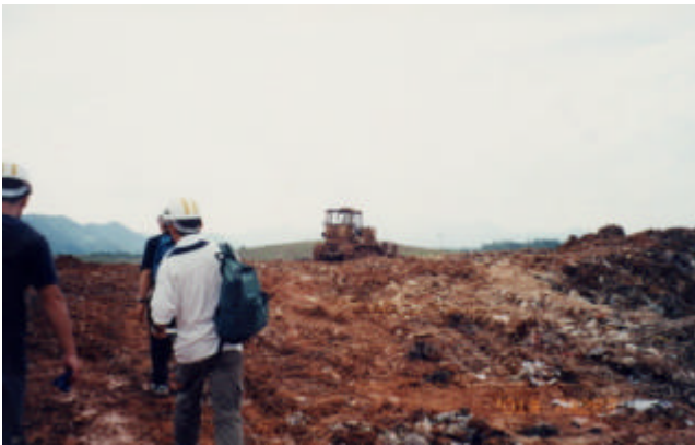
処分場の第1期で建設されたセクション1が満杯になったため、現在はセクション2で埋立てが行われている。毎日1200トンほどのゴミを処分し、今年(2001年)末までにこのセクション2も満杯になると推定されている。
