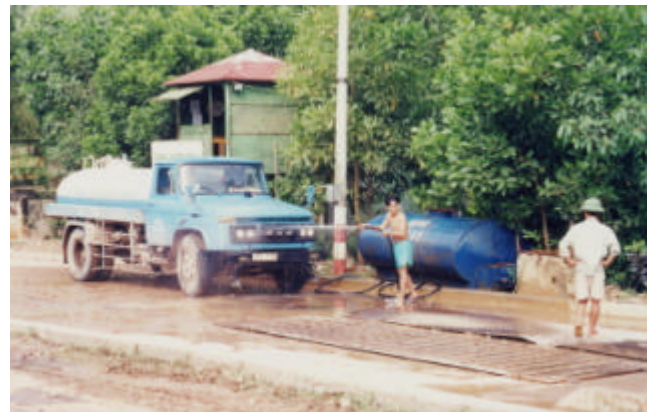
出口で設置されている洗車場。
