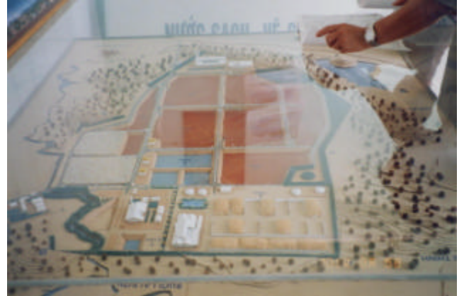
ナムソン最終処分場の全景を示す模型。敷地面積は全体で83ha。用地収用が完了し、敷地の周囲は柵で囲まれている。ハノイ市から発生するゴミを2018年まで埋立て処分する予定である。
