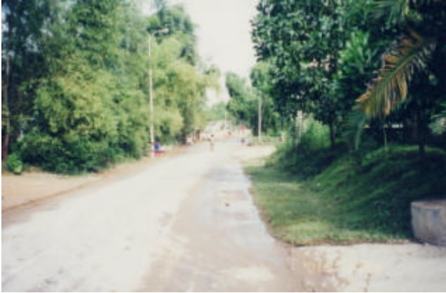
ナムソン最終処分場へのアクセス道路。同処分場の建設に伴って1997年から整備された。道路の両側に、夜間に通行するゴミ運搬車のために照明電灯が設置されている。
