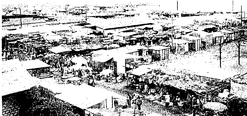
アクセス道路 道路上に露店が建ち並んでいる
