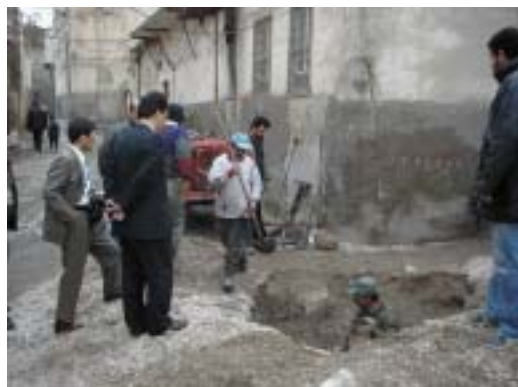
フェーズ1 給水管工事状況
