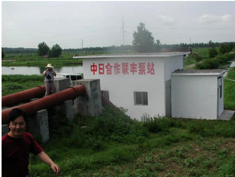
高場モデル地区（排水機場）
