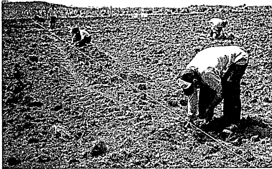
写真No.53 植栽位置の標示と植付け作業
