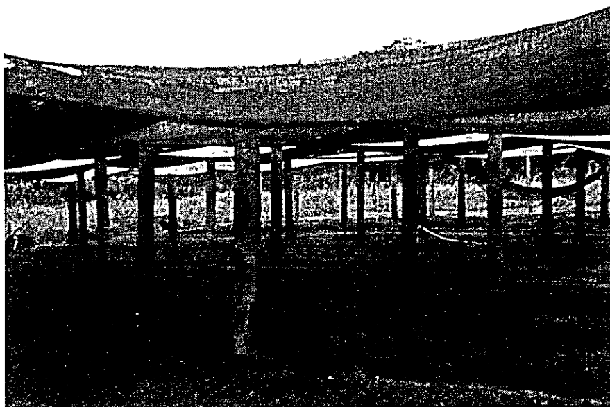
写真No.7 日覆い（高張り）
