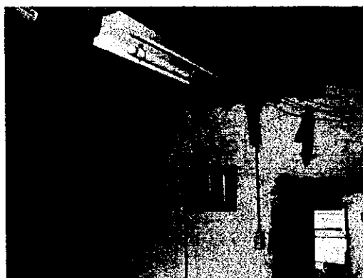
La lámpara instalada
