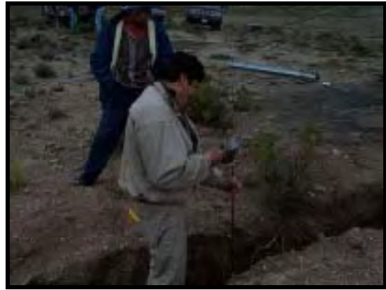
(b) 接地工事
