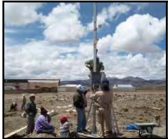
(d) 各種センサーの取付工事
