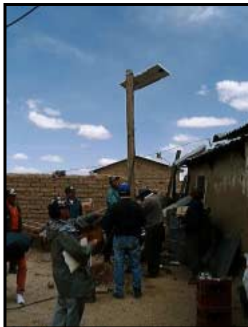
PV システムの設置
