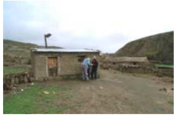
PV システムの設置が完了した家屋
