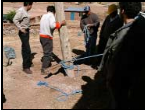
シカ・シカ村落の PV システム撤去
