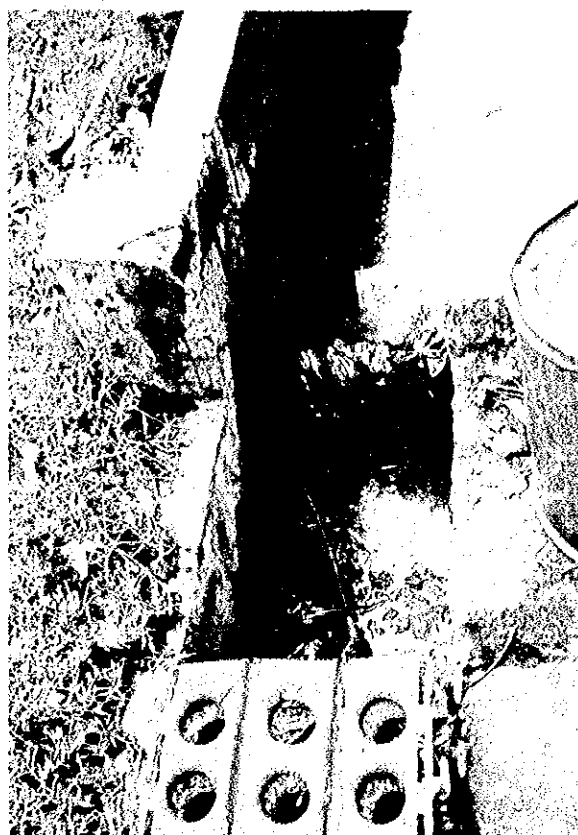
6. 排水路にはヘドロがたまり、異臭が漂っていた
