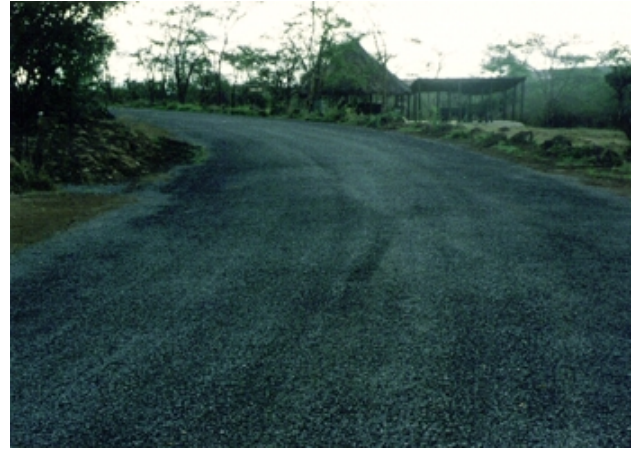
簡易舗装された道路
