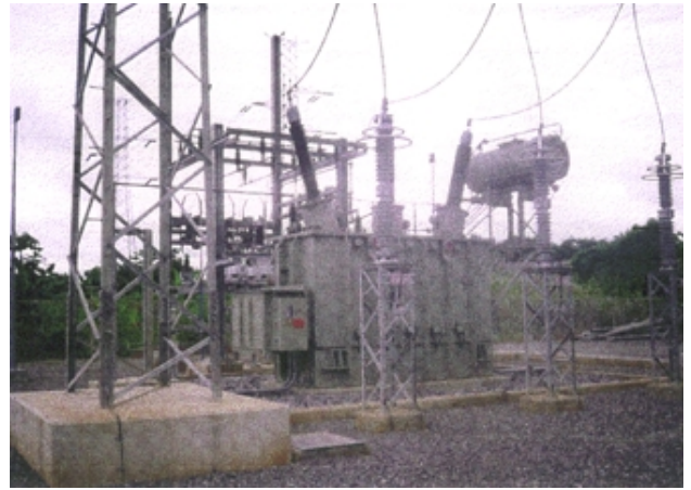
新しく設置された変電機
