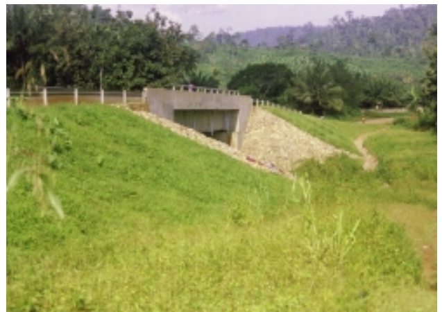
整備された橋梁。維持管理状態も良い
