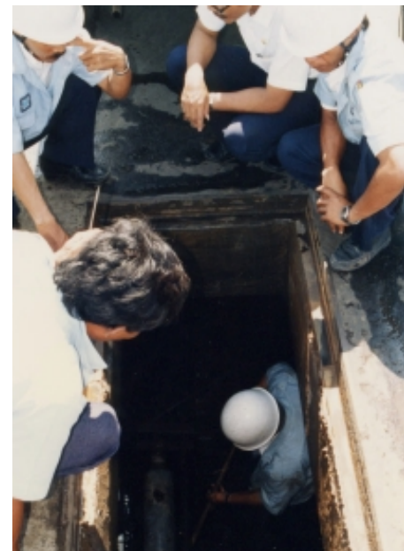
埋設された電話線路の点検を行うカウンターパート
