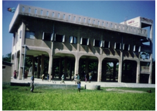
無償資金協力によって建設されたサイクロンシェルター。普段は学校として使用されている
