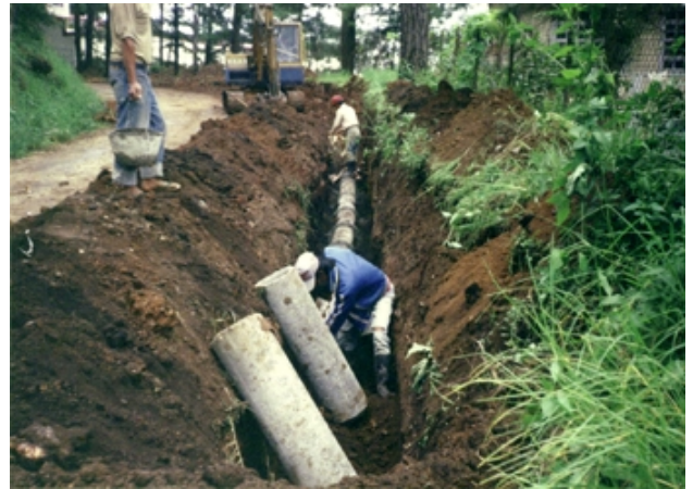
バギオ市によって下水管の敷設が進められている
