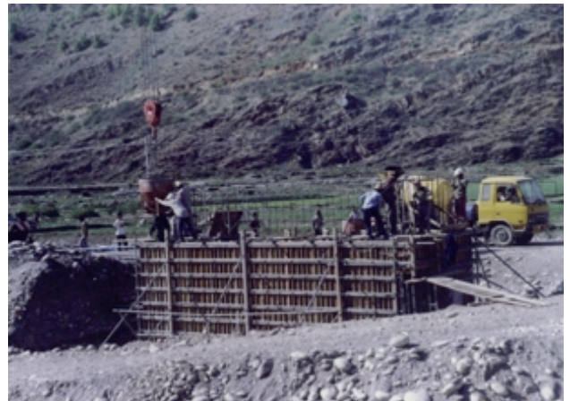
建設中の橋梁
