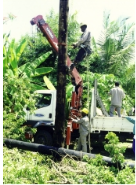
電柱の交換を行うカウンターパートたち
