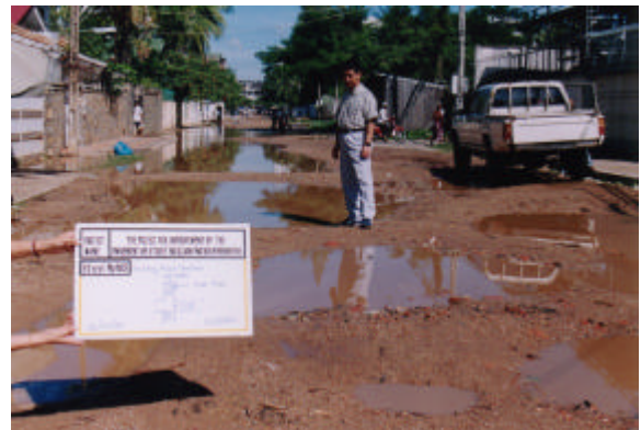
舗装改良前の No. 105 通り
