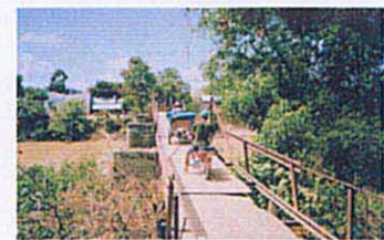
破壊された橋梁に 応急的な橋を架けたもの
