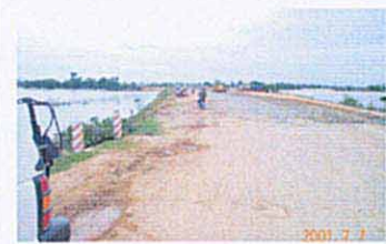
郊外部の開発状況
