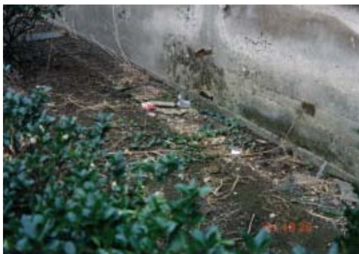
写真1 - 9 - 4 建物脇（改善後2）
