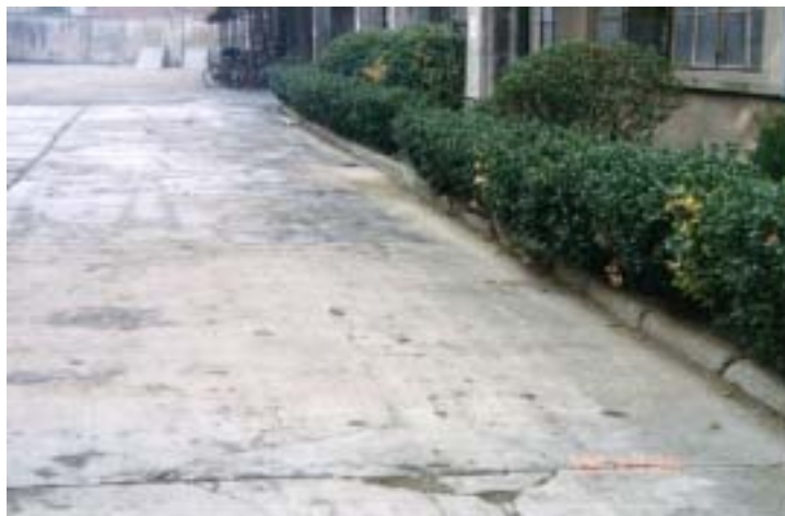
写真1 - 9 - 3 屋外通路（改善後1）
