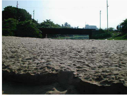
Dehiwala Canal 出口
