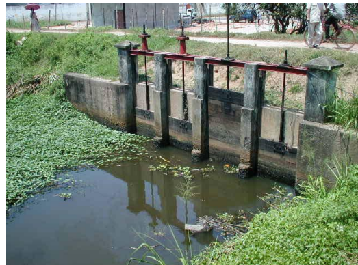
オールド・ネゴンボ水路のゲート
