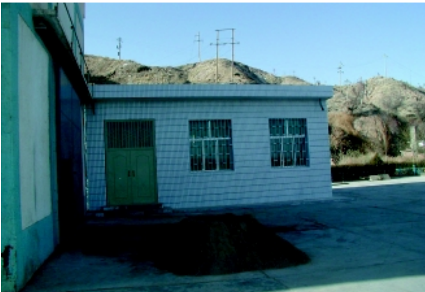
甘肅省景泰川灌溉区ポンプ場操作室 (本プロジェクトのため中国側により操作管理装置のための家屋が建設されている)
