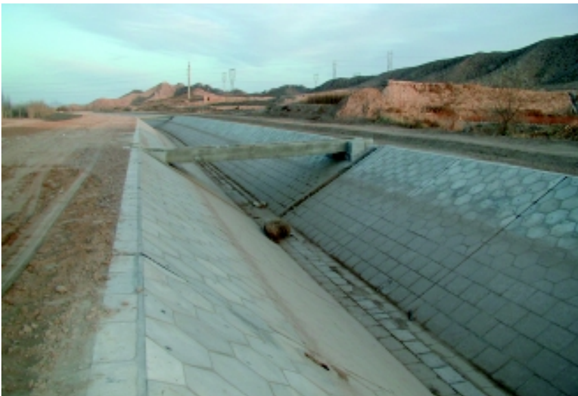
甘肅省景泰川灌漑区基幹水路 (開水路、本プロジェクトのモデル事業の一環として中国側により改修が実施されている)
