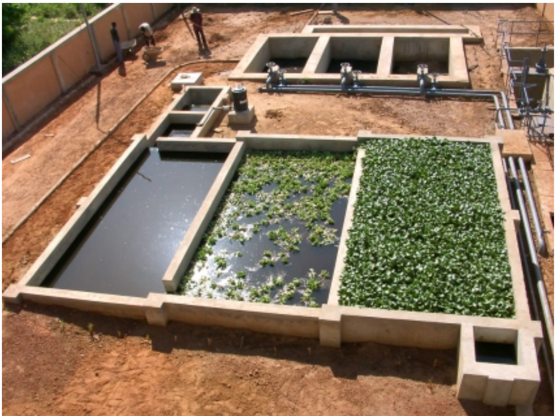
エコポンドと汚泥乾燥床
