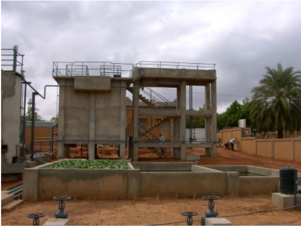
UASB 装置とバイオタワー
