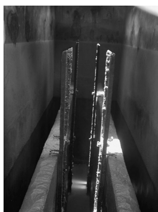
ろ過池: ほとんど砂が流失してなくなっている層は逆洗が不十分なため、濁質が蓄積している
