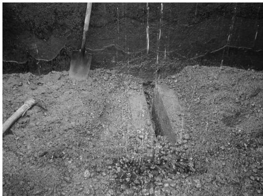
ろ過池下部集水装置、溝のあるタイプで、ほとんど 砂利しが残っていない
