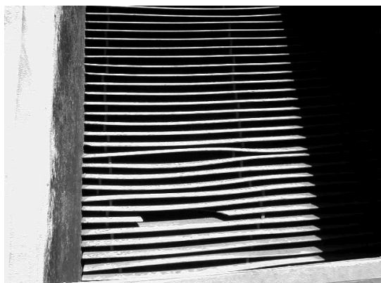
沈殿池アスベストス傾斜板：設置後15年程度であるが湾曲・脱落している
