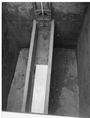
ろ過池: ほとんど砂が流失してなくなっている層は逆洗が不十分なため、濁質が蓄積している
