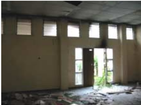
Lecture Room 1-2 : No door
