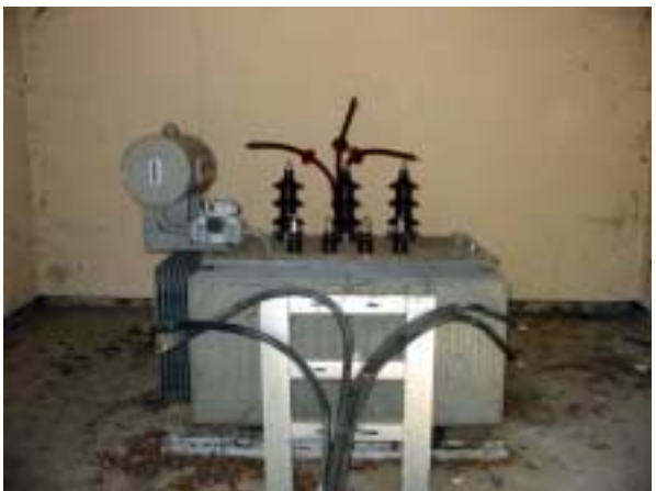
Transformer : 400kVA
