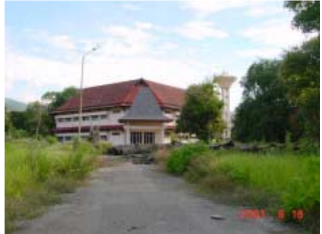
物理化学実験棟：改修後、新管理・講義棟になる 建物右側が高架水槽。
