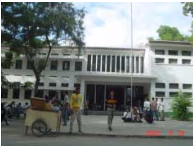
東チモール大学本部棟：工業高校だった建物を USAID が改修を行い,大学本部として使っている。
