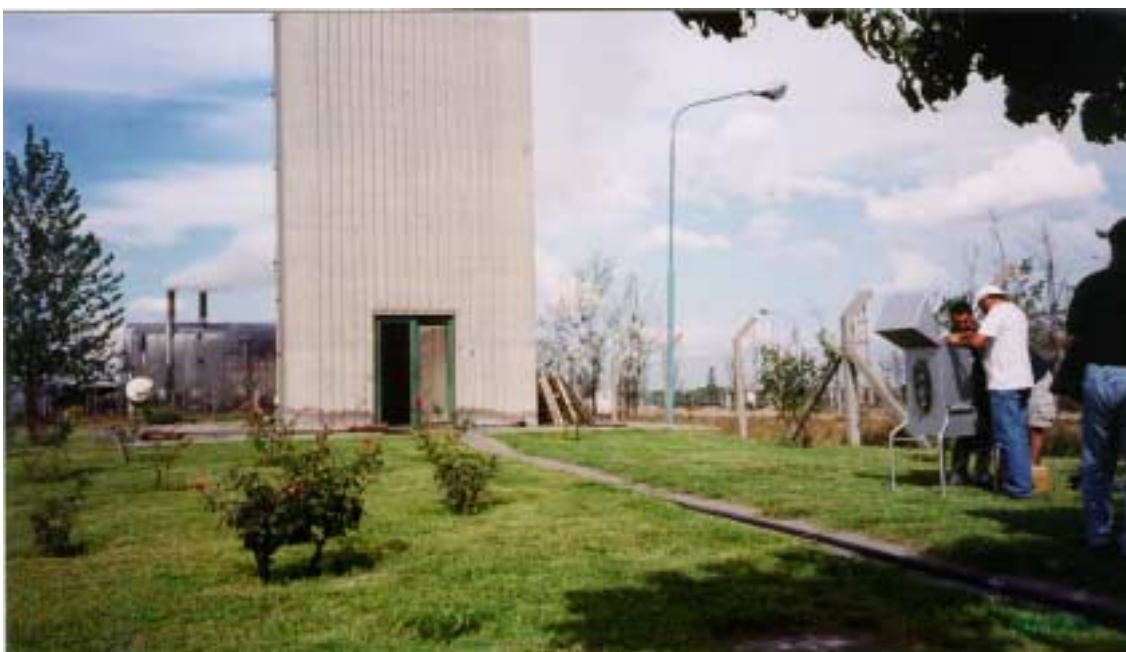
Aceros Cartellone S.A. in the Lujan de Cuyo Area
