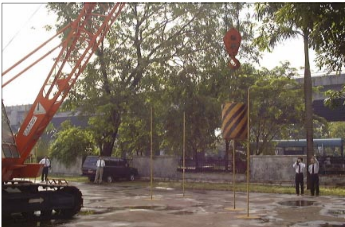
移動式クレーン運転
