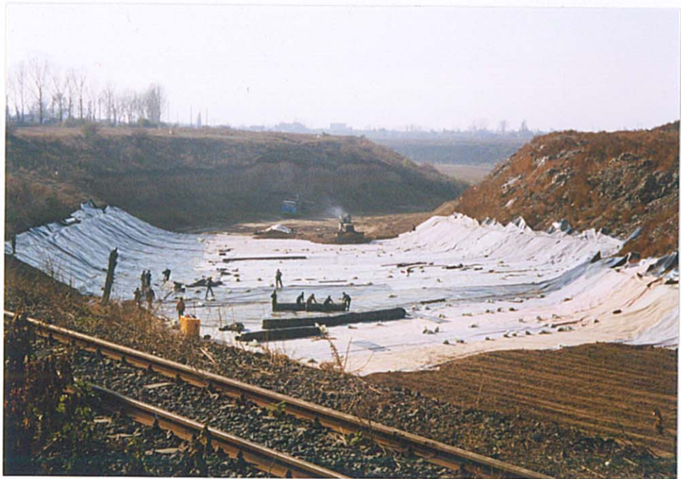
グリナ廃棄物処理場（２）シート被覆工事現場
