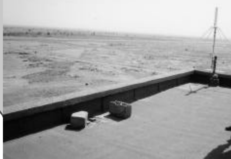
1. Station Datum de l'aéroport
