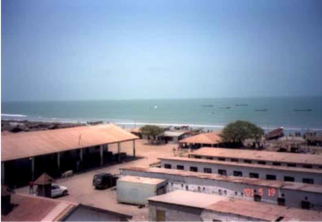
サイトの現状（１）：鮮魚取扱棟等の本プロジェクトにおける主要施設が建設される予定地である右側サイトの現状を陸側より望んでいる。写真右側部にある既存漁具ロッカーが移設され、その跡地に鮮魚取扱棟が建設される。
