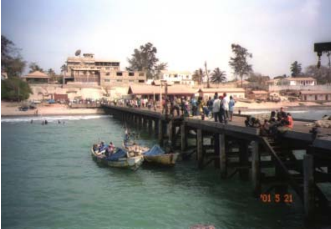
類似案件の状況（１）：1992 年度実施の沿岸零細漁業振興計画により建設されたバカウ水揚場施設の現状を海側から望んでいる。水揚された魚類が後背にある荷捌場で取引されている。
