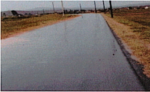
写真⑰ 国道 58B 号線 PK2+00 付近の現道
