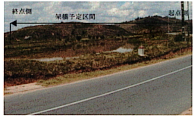
写真⑱ 架橋計画位置 RN58B.PK3+200 現況
