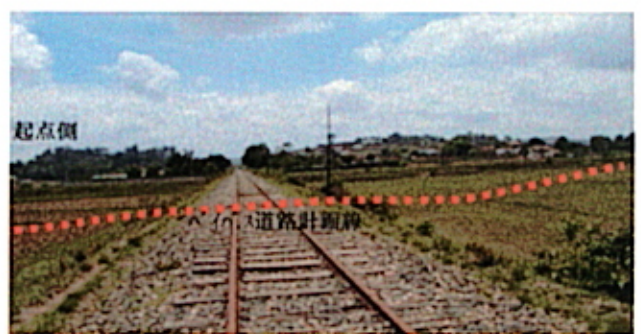
写真⑧ 既存鉄道上で首都方向へ向かって撮影
