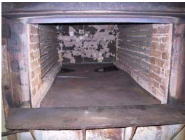
写真 2 - 4 - 1 歪取焼鈍炉（バッチ炉）
