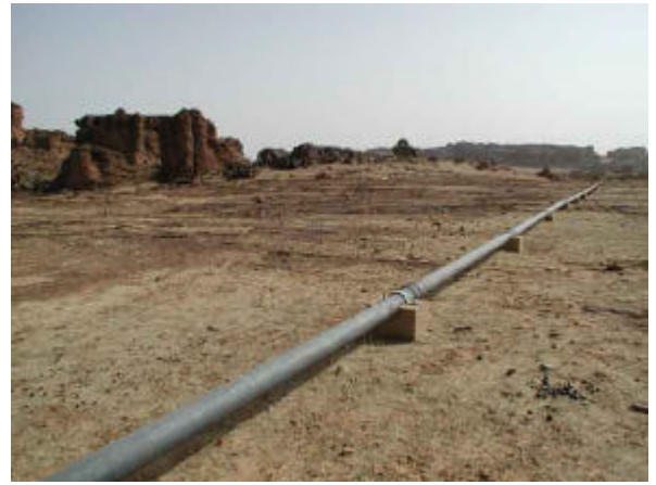
井戸から配水池までの送水管路
