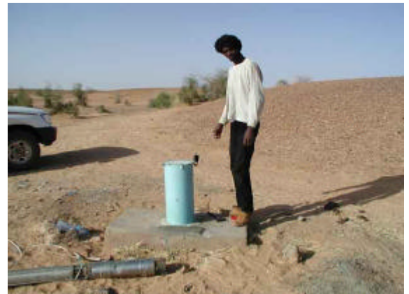
JF-7B 揚水ポンプ場
