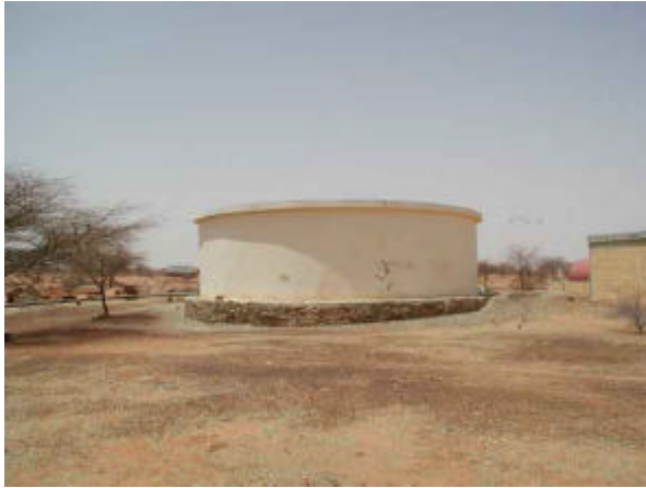
高台にある配水池
