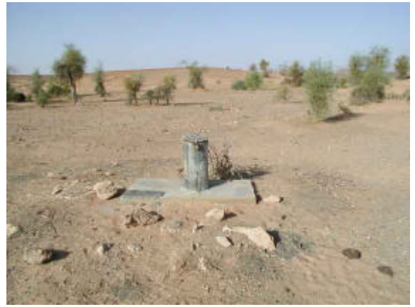
JF-2 揚水ポンプ場
