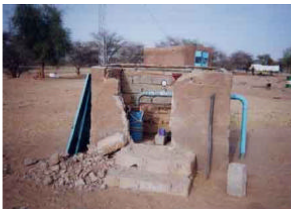
F5 揚水ポンプ場
