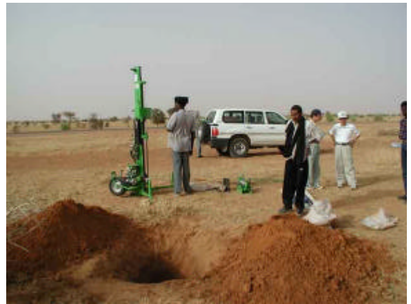
送水ポンプ場予定地
