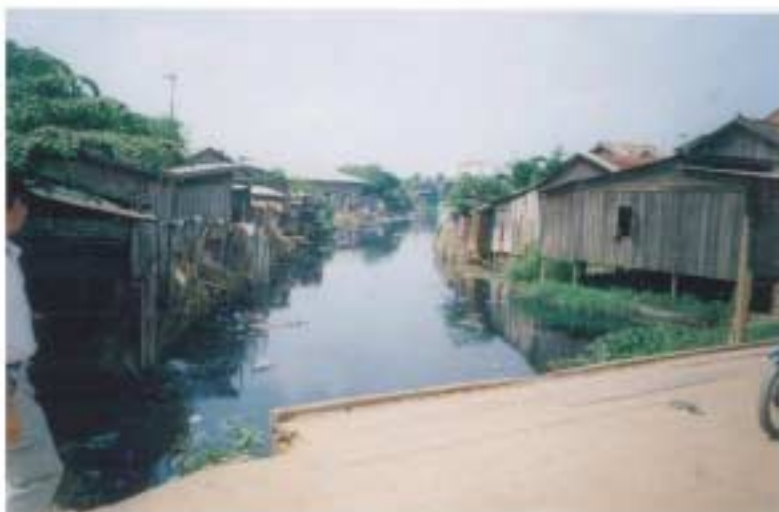
Salang 排水路改修区間最上流地点の橋梁上から下流側を望む。
