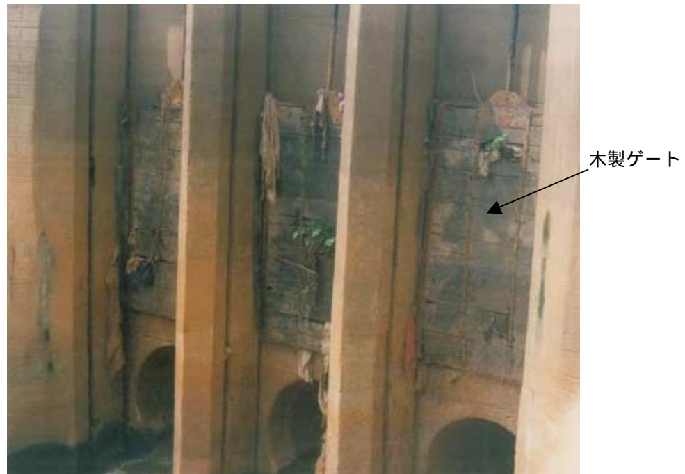
写真：Svay Pak 排水樋管外水側(下流側)木製ゲートの現況
