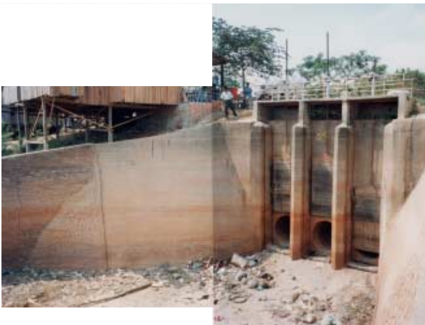
排水樋管下流側ゲート及び翼壁。老朽化が著しい。
