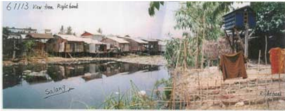
Salang 排水路を右岸側より望む。
