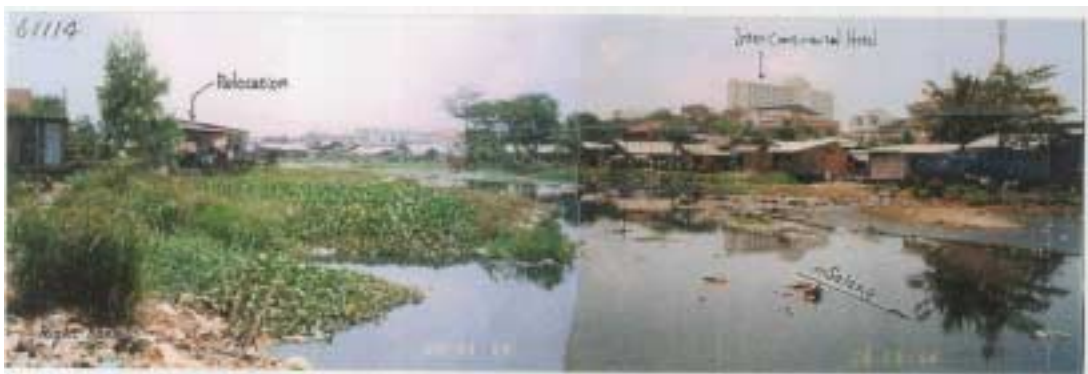
Salang 排水路を右岸側より望む。
