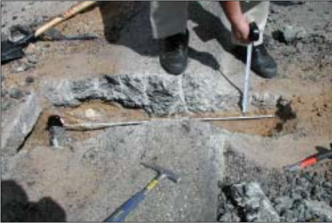
アスファルト舗装の試掘状況 平均厚は15cm
