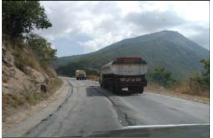
轍掘れを避け反対車線を走行する タンク・ローリー
