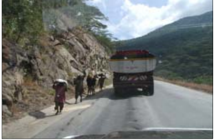
山側側溝が歩行者道となっている 年に1回程度の人身事故が発生している
