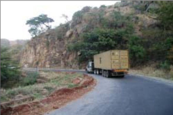
キトンガ峡谷 (KP 442+400) 蛇籠による谷側補強部の一部に 崩壊の兆候が見られる
