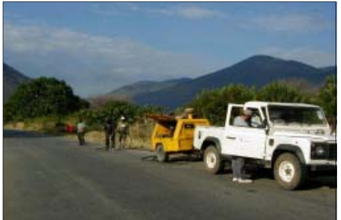
TANROADSの発注によるポットホールの修復状況 維持管理実施体制は充分であることが伺える
