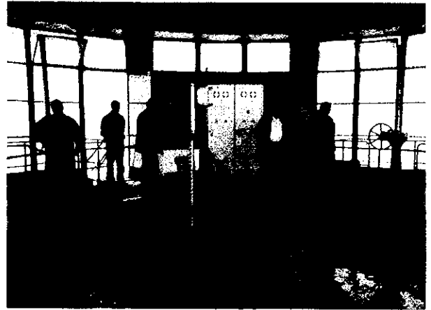
沈澱池分電盤
