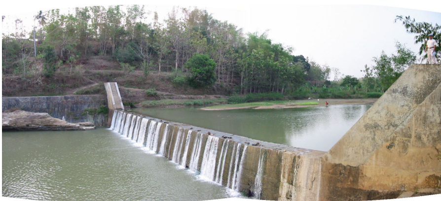
5. クドゥワン川既設砂防ダム
