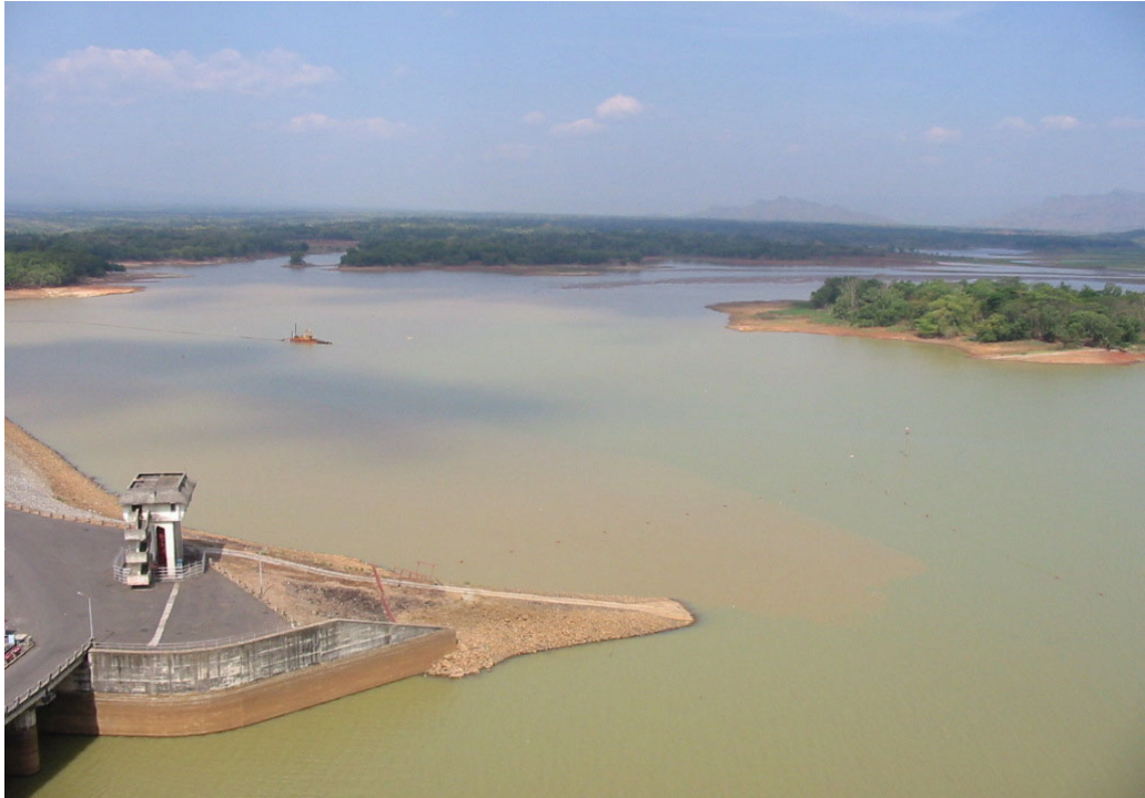
1. ウオノギリ多目的ダム取水口付近
