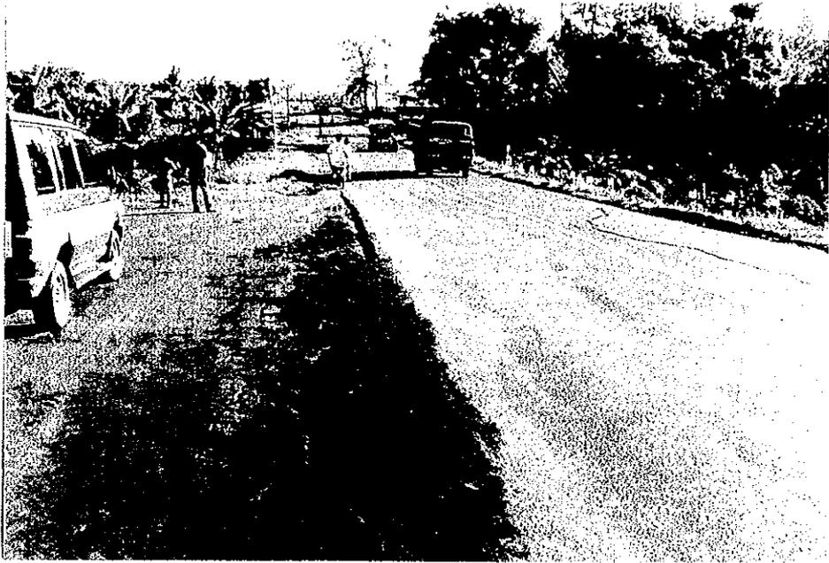
地震により生じた舗装道路の亀裂
