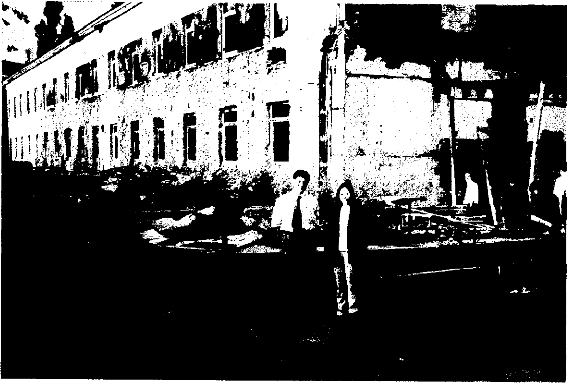
建設中の「環境工学コース」設置予定校舎
