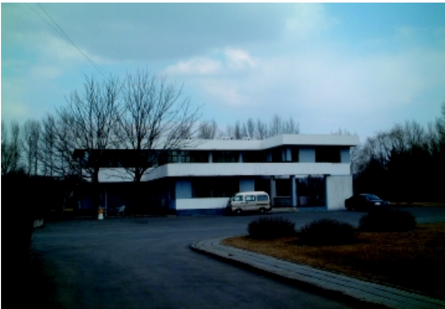
プロジェクト事務所 (同センター内)
