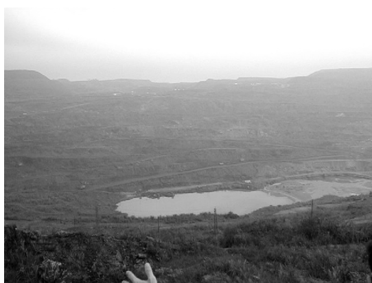
コックサウ炭鉱露天掘ピット
