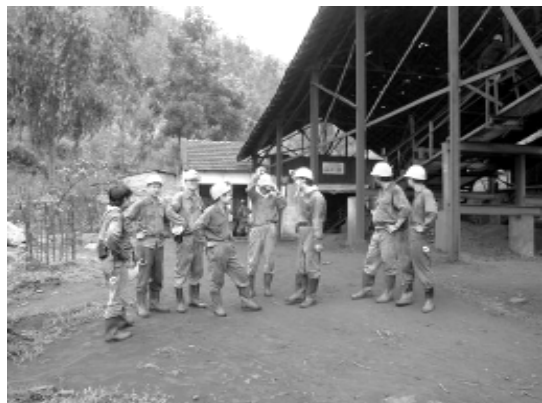
ベルト斜坑 -25m 坑口
